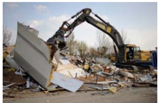
Séparation des ferrailles, bois et tout-venant à l'aide d'une pelle mécanique, Xynthia 2010 (Robin des Bois).
